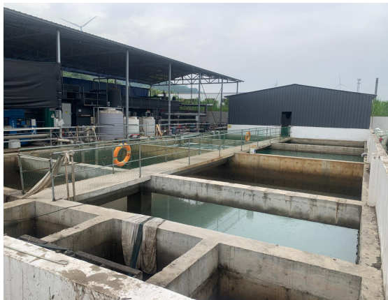
污水处理区蓄水池
